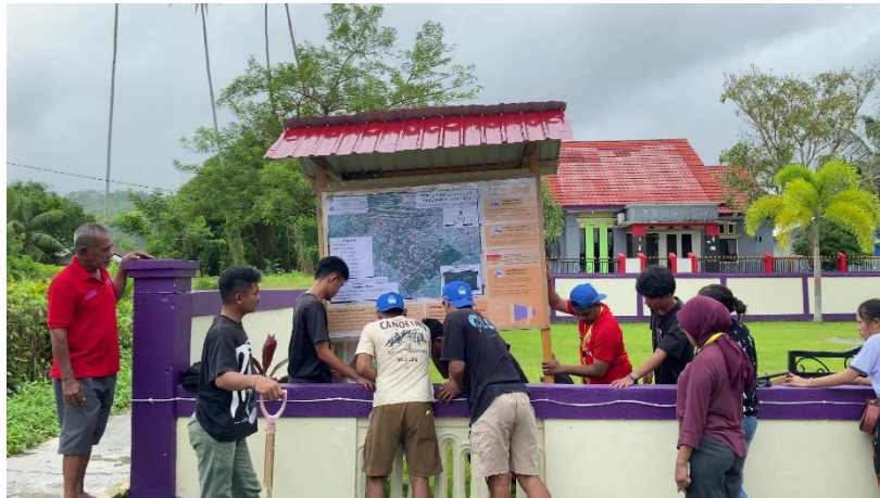
Gambar 8. Pemasangan papan informasi jalur evakuasi di lingkungan Gereja Maranatha Kelurahan Namasina
