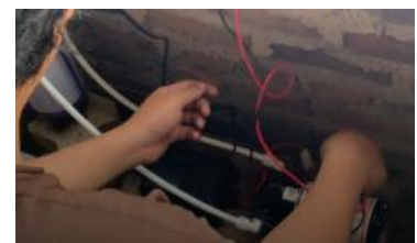
(c) pemasangan pompa dc
