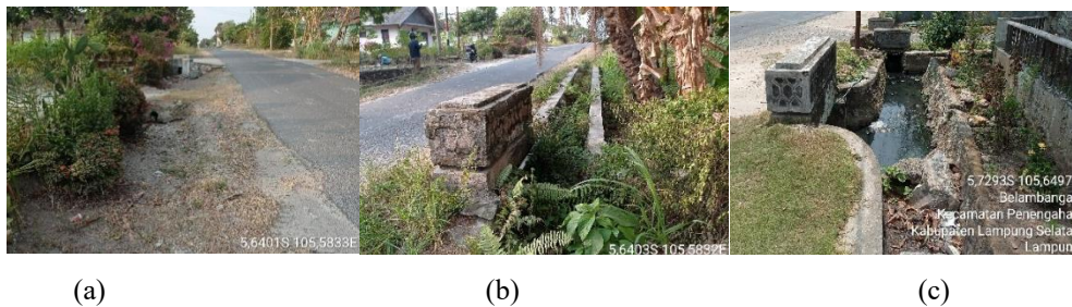
Gambar 2. Ruas jalan tanpa drainase (a), Sedimentasi akibat rumput liar (b), Sedimentasi akibat sampah (c)
