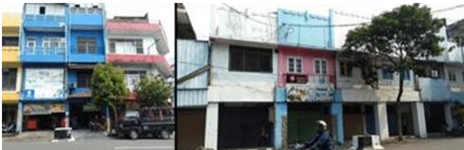
Gambar 3. Fasade representatif bangunan cagar budaya di Jalan Kembang Jepun, Surabaya.
