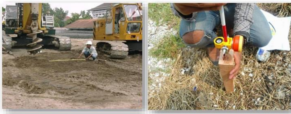
Gambar 5. Set up alat berat dan titik bore pile .
