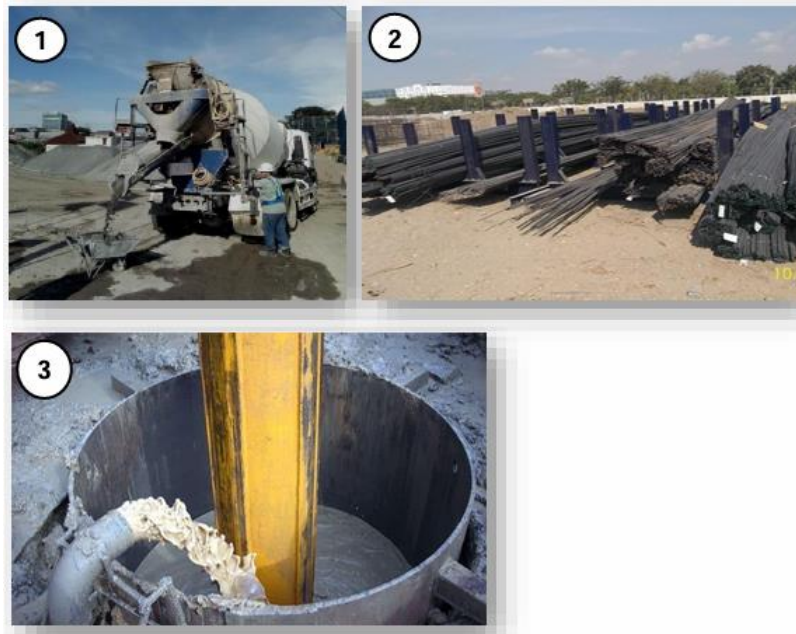
Gambar 2. Beton ready mix (1), Baja Tulangan (2), Bentonite Slury (3).
