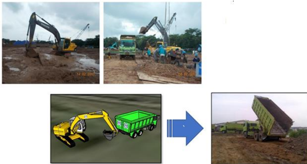
Gambar 13. Proses pembuangan lumpur setelah pekerjaan bore pile selesai.
