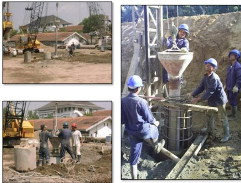
Gambar 11. Pemasangan tremie dan pengecoran.
